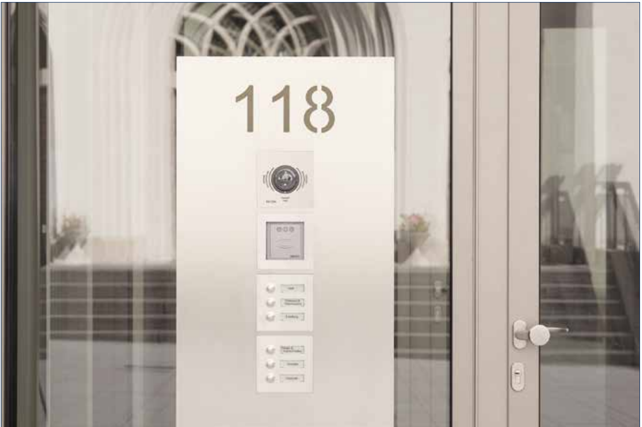
Адміністративна будівля католицької церкви, м. Штутгарт, Німеччина (фото: Дірк Вільгельмі)
